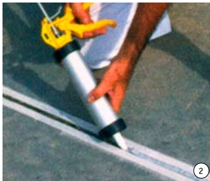
Операции герметизации швов: 1 – укладка уплотнительного шнура, 2 – заполнение герметиком
