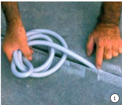
Операции герметизации швов: 1 – укладка уплотнительного шнура, 2 – заполнение герметиком
