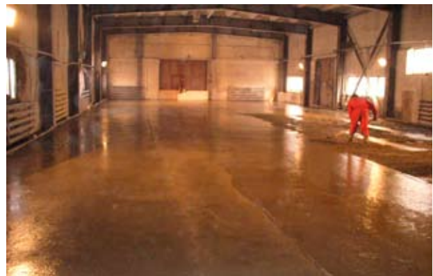
Рис. 2. Заливка фибробетона Pic. 2. Fibre-reinforced concrete placing
